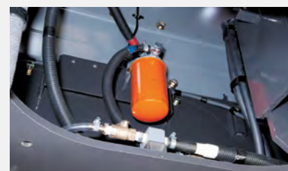
Точки контрольного осмотра, расположенные за нижним кожухом
