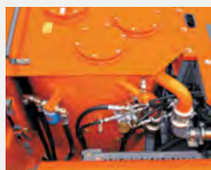
Фильтры на стенке центрального прохода
